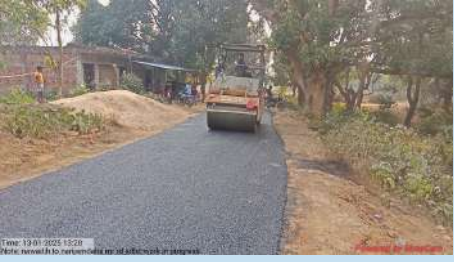
पथ का निरीक्षण एवं पर्यवेक्षण का किया गया कार्य
